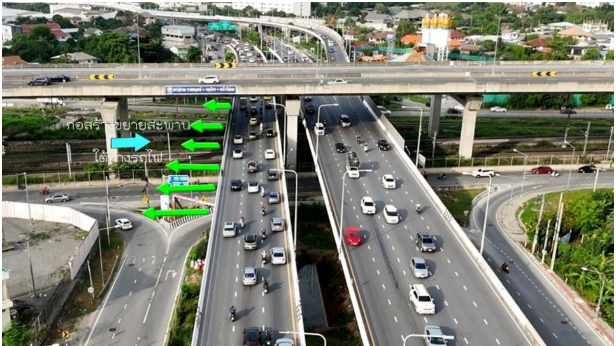
รูปที่ 9-6 ตำแหน่งงานก่อสร้างขยายสะพานข้ามทางรถไฟของโครงการ
